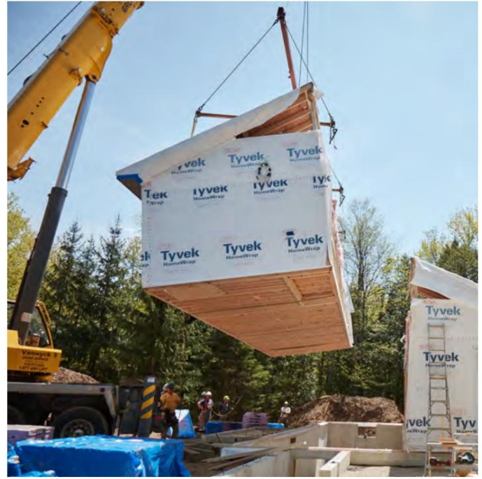
图 1:起重机将模块降到地基上。
