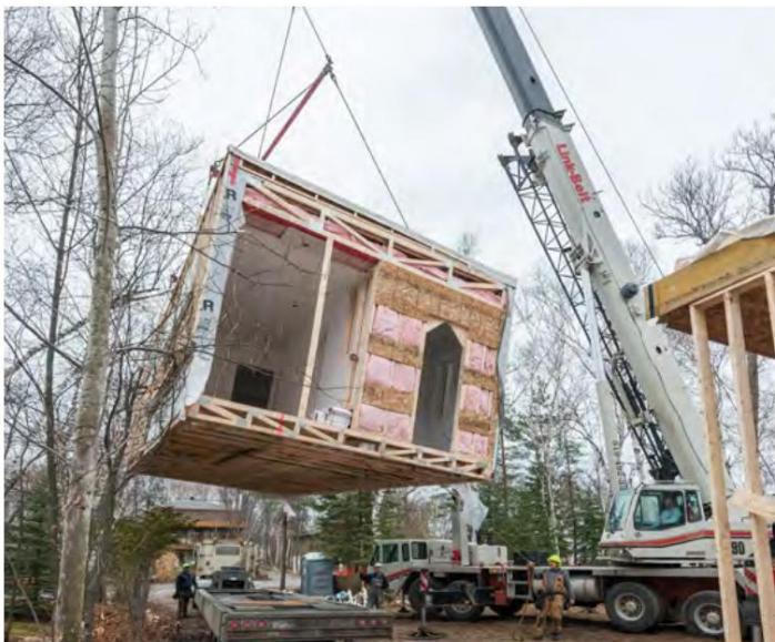
图 13:一台起重机从平板卡车上吊起一个模块。
