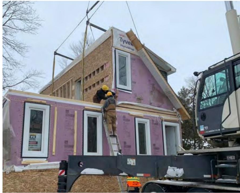
图 9:工人将二层模块用起重机移动后固定到位。
