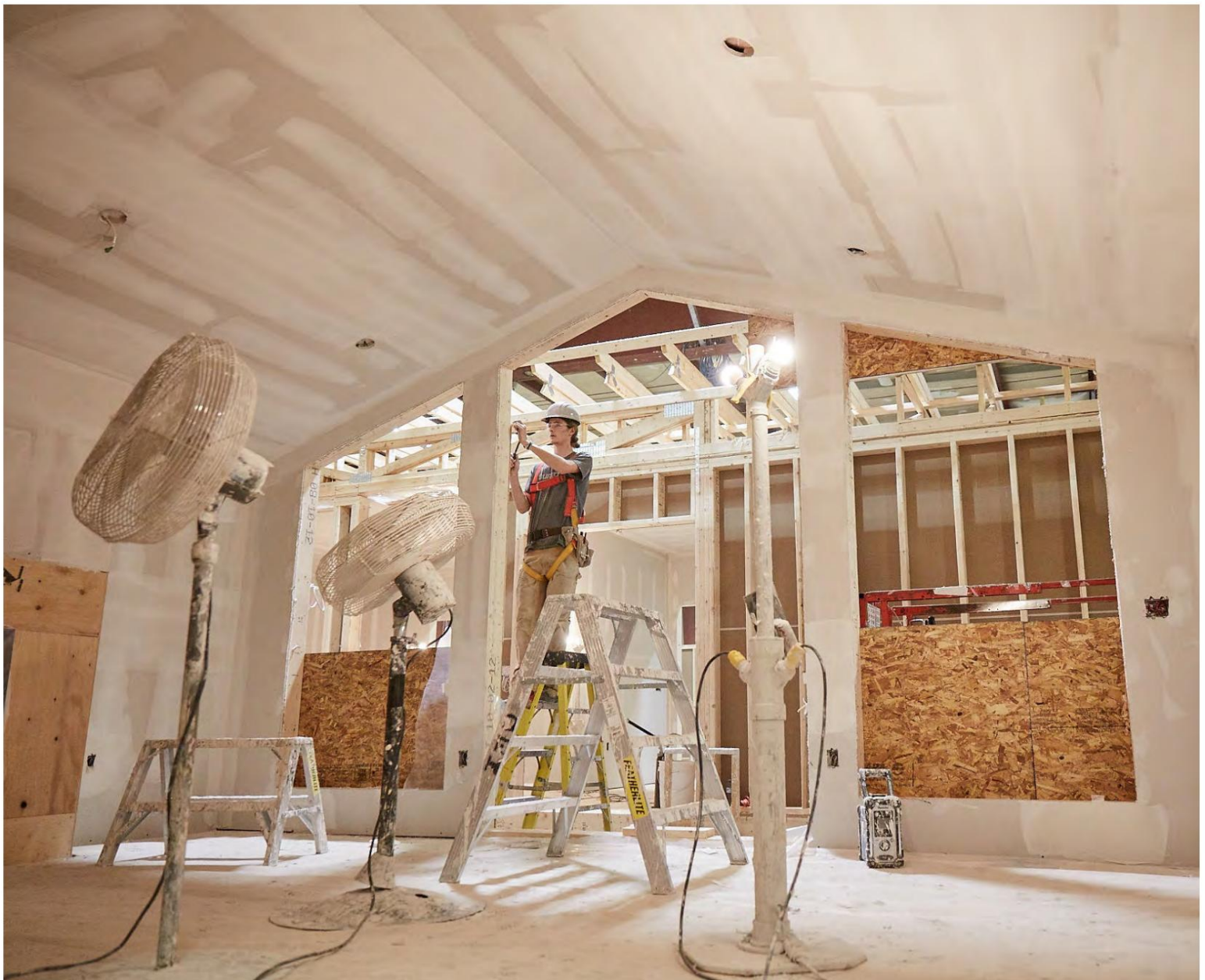
图 16:模块内部安装的石膏板。
